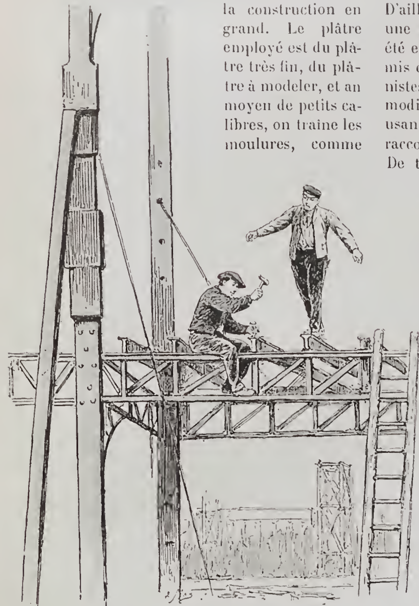
Ajustant et fixant les fers de planchers.
